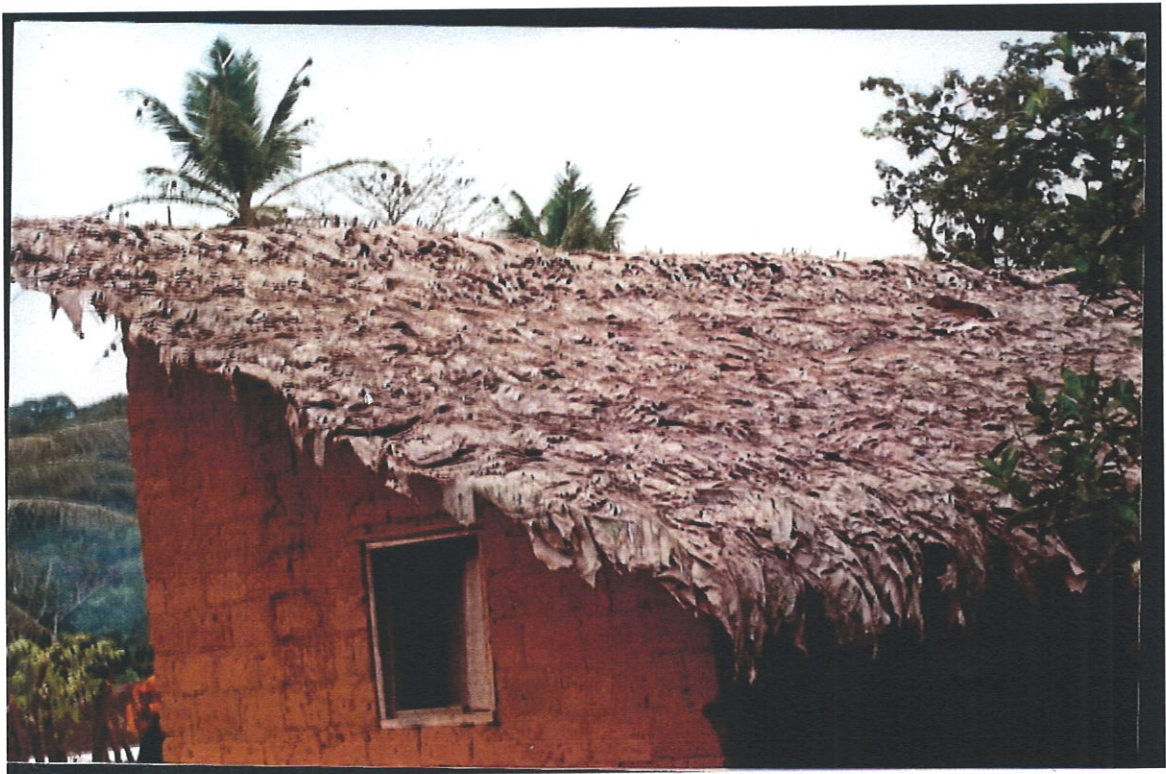
Photo n° 7 : Toiture de la maison construite avec les feuilles de différentes espèces de Marantaceae .
