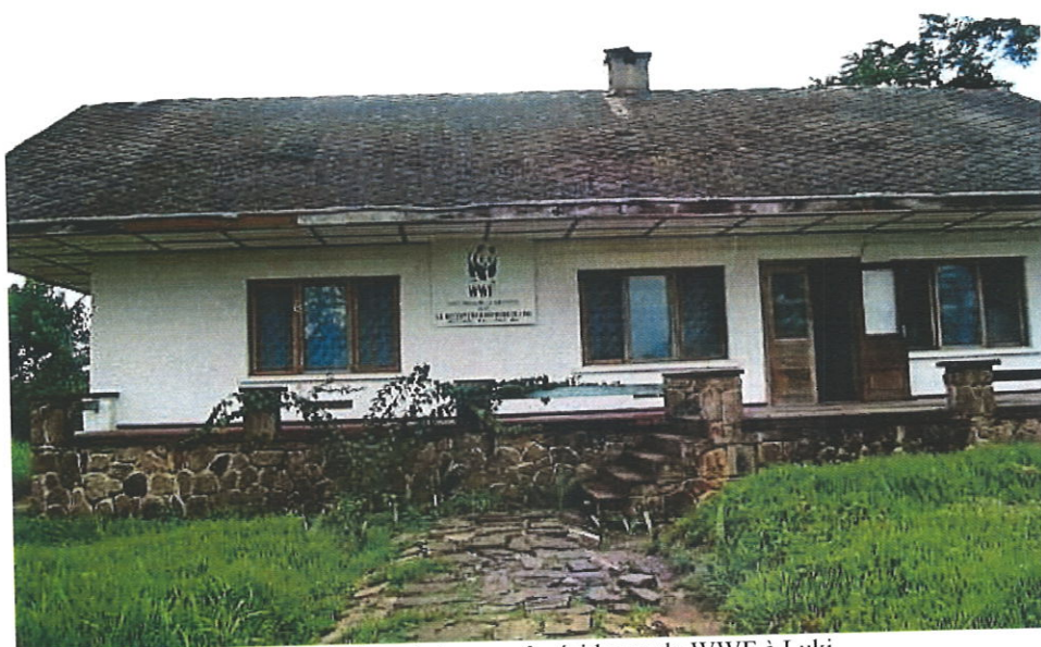
Villa abritant le bureau & résidence de WWF à Luki.
